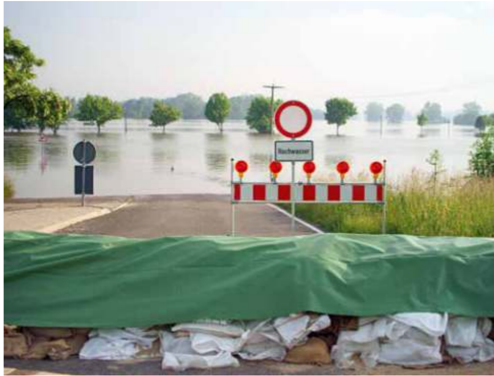
Kein lästiges Sandsäckeschleppen mehr: Mobile Hochwasserschutzsysteme eignen sich als Alternative zu stationären Maßnahmen.
