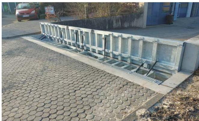
**Bild 4** Geprüftes Schutzsystem der Gruppe O5 (modernes automatisches Klappschott in Funktionsstellung)
