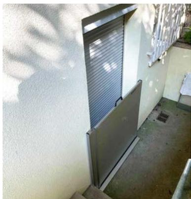
**Bild 3** Geprüftes Schutzsystem der Gruppe O2
