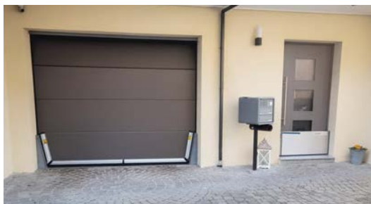
Bild 3 Garage mit selbstdichtenden Tor und Hauseingang mit Damplatte
