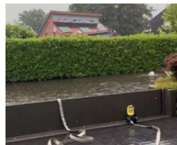
Bild 5 Klappschott in Funktionsstellung an einer Grundstückseinfahrt bei Hochwasserbeanspruchung
