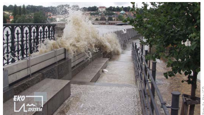
Bild 2 Mobiles Schutzsystem der Beurteilungsgruppe L-Landschafts- oder Linienchutz aufgebaut zur Erhöhung einer Ufermauer an der Moldau
